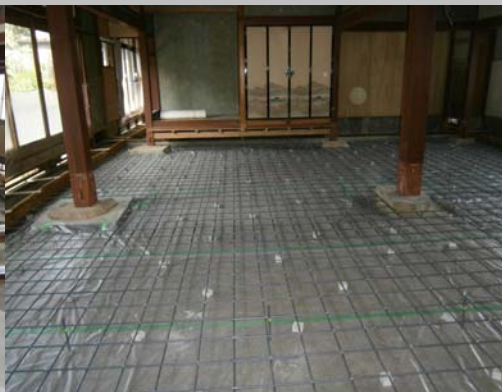
ベタ基礎打つ前のメッシュ加工
