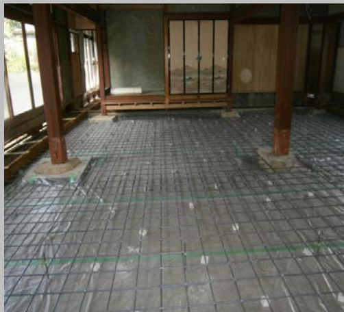
ベタ基礎打つ前のメッシュ加工
